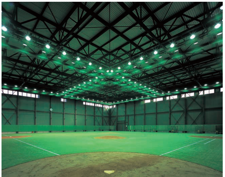
屋内練習場の照明：1kW金属ハライドランプ矩形配光投光器を採用し、高照度を確保しながらグレアの低減を図っている
