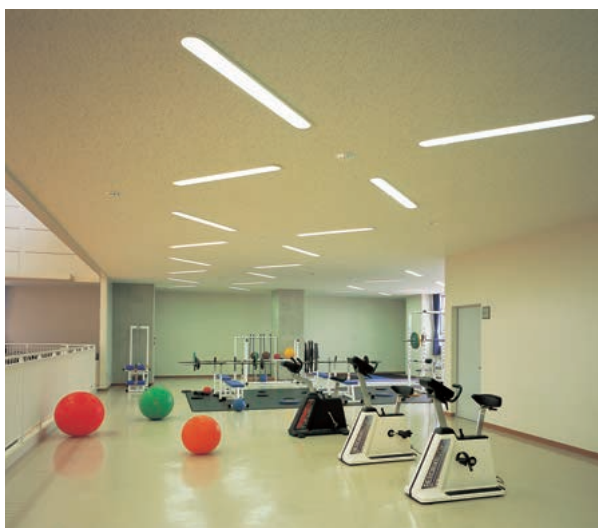
トレーニングルームの照明：32WHf蛍光ランプ埋込カバー付器具を放射状に配置。中央には蛍光灯ダウンライトを設置
