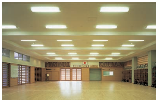
剣道場の照明：105WHiコンパクト形蛍光ランプ・グローブ付器具を採用
