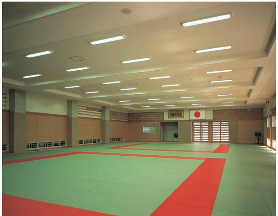
柔道場の照明：105WHiコンパクト形蛍光ランプ直付器具を設置。的確な判定ができるよう均一な明るさとグレアの低減を図っている
