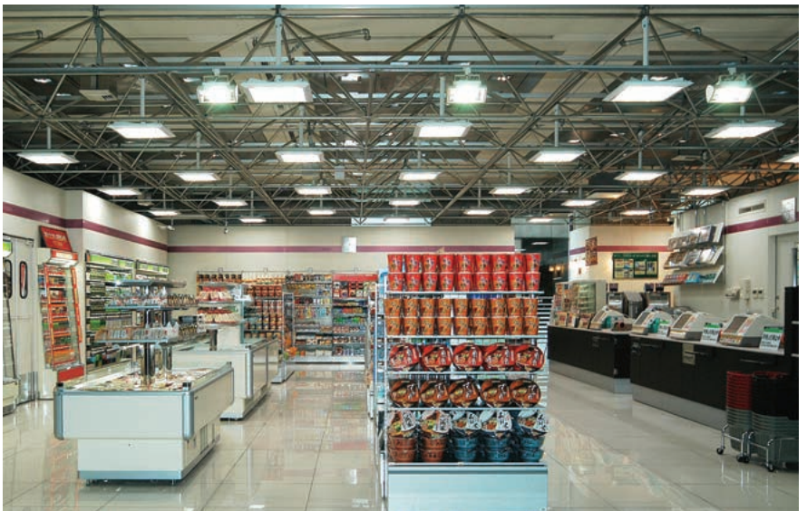
フルオープンとした入口部分から奥を望む：ネオスクエアⅡを千鳥配置で床上3.0mに設置
