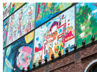
正面側壁面に1列に配置した投光器
