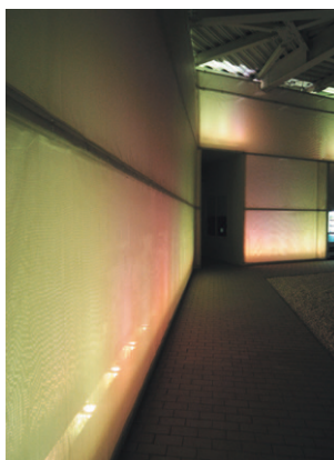
光幕の内側上部と下部にハロゲンランプカラーフィルター付投光器を設置
