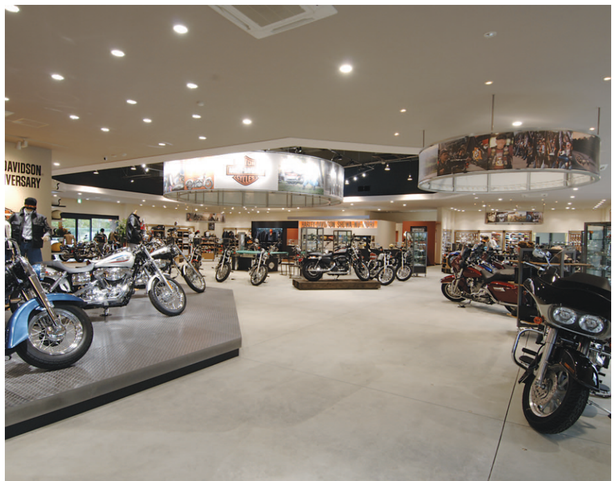
店内売場の照明：ベース照明は100Wセラミックメタルハライドランプダウンライトを採用
