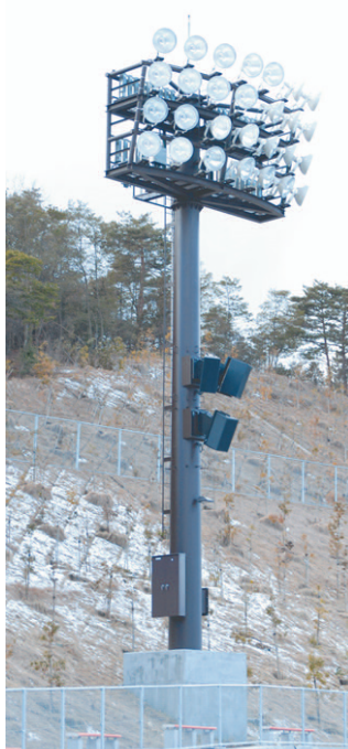
NO.6の照明塔
