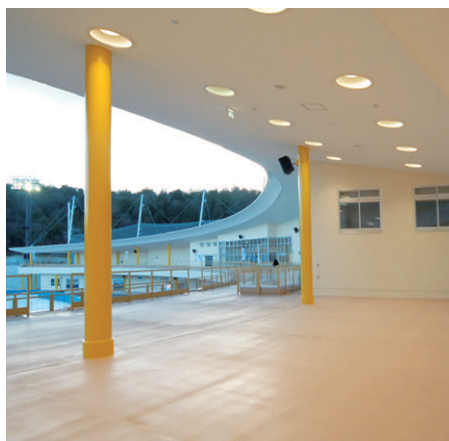
2階にあるイベントロビーの照明：400Wメタルハライドランプダウンライト（電動昇降装置付）を設置
