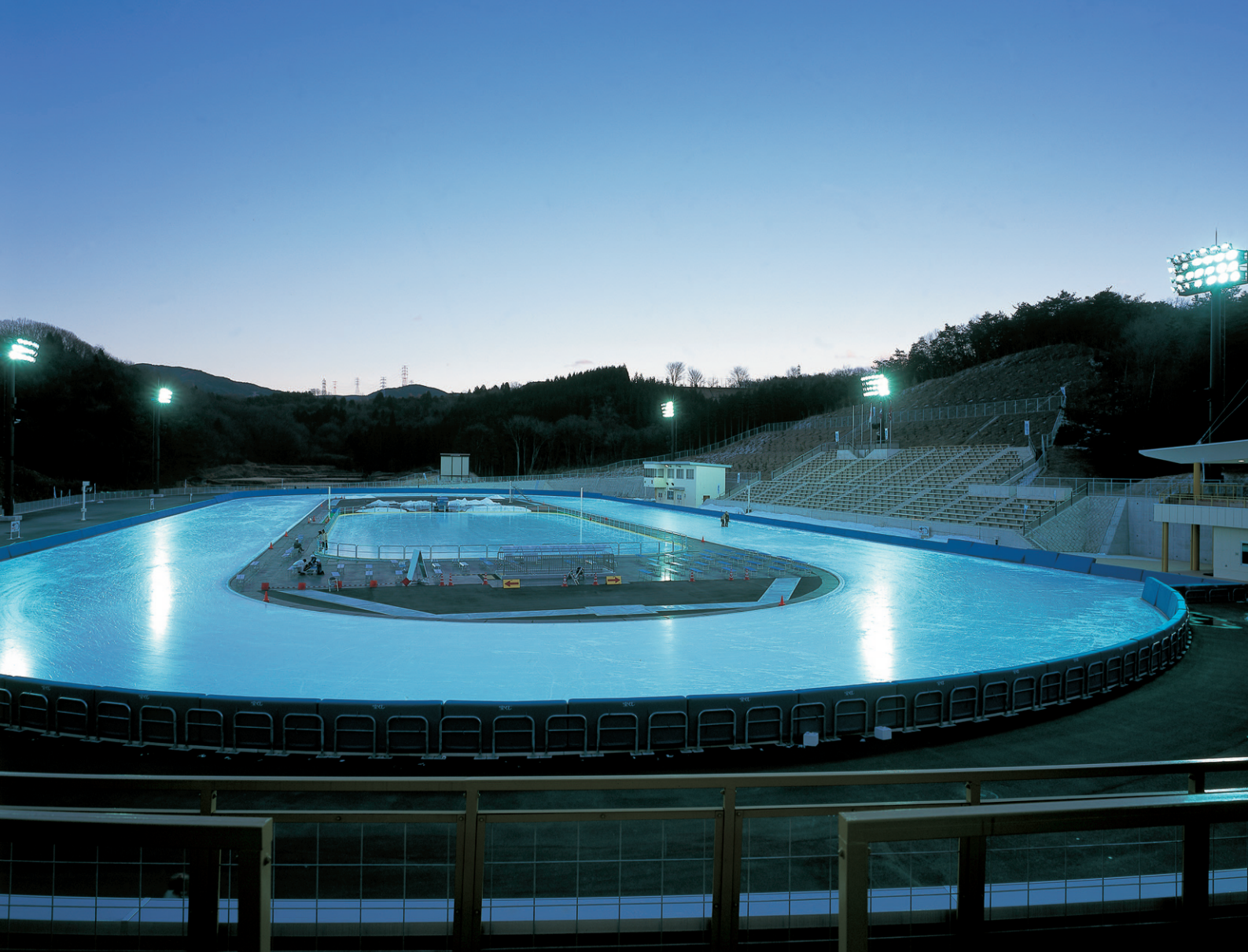
センターハウスから夜間照明されたアイススケートリンク全景を望む：JISアイススケートリンク（屋外）の照度を満足しながら眩しさを軽減している
