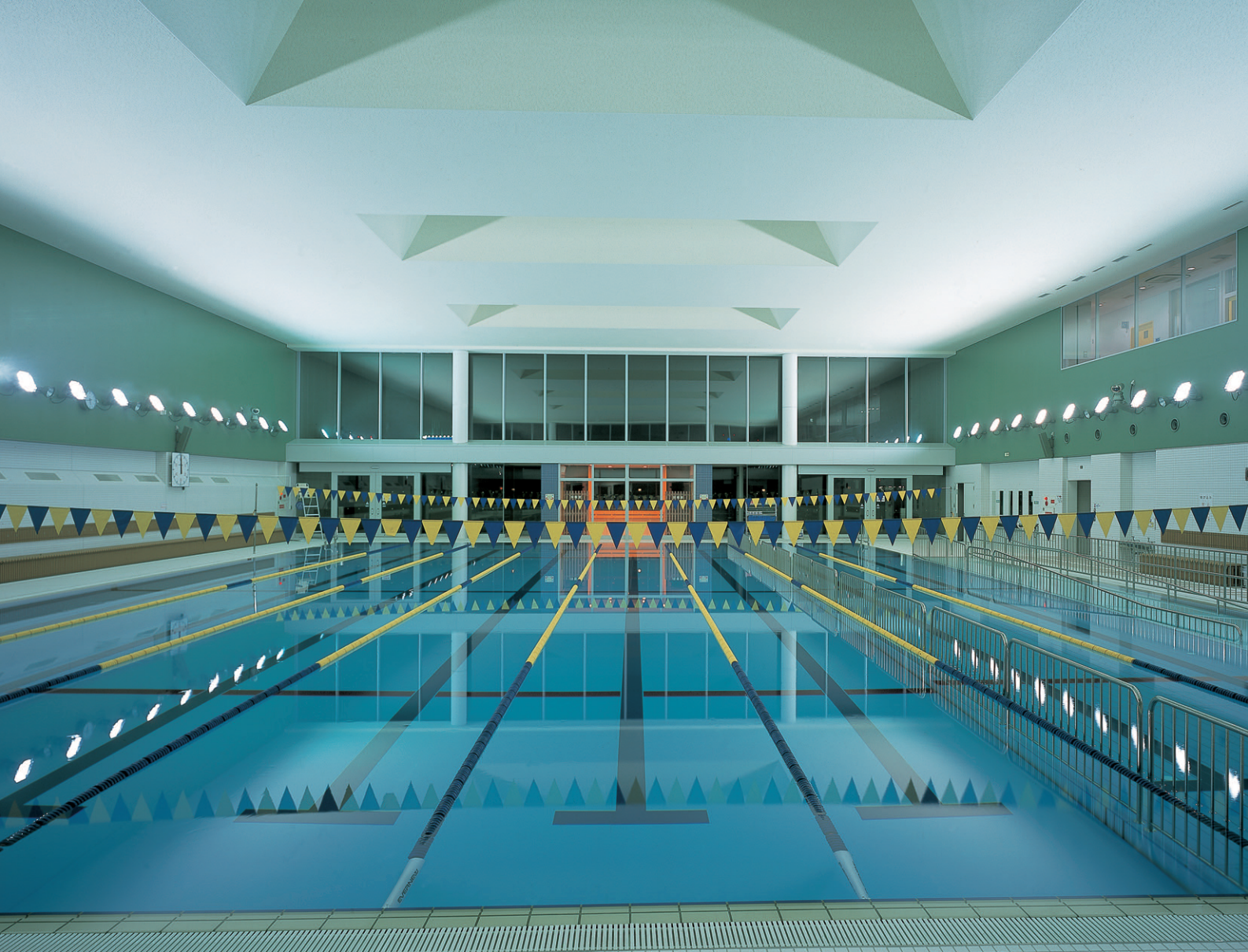
温水プールの照明：400Wメタルハライドランプ投光器を斜め上方向照射とした間接照明方式
