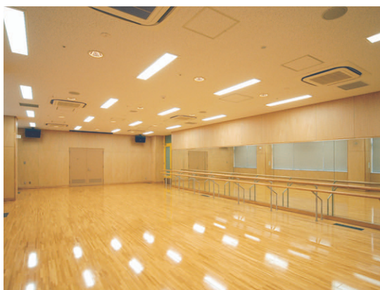
多目的室の照明：32WHf蛍光ランプ2灯用埋込器具と100W白熱電球ダウンライト調光形を採用
