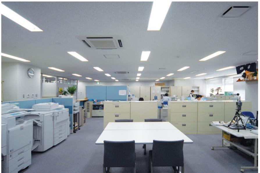
オフィスフロアの照明:32WHf蛍光ランプ2灯用埋込器具連続調光形(25~100%)をライン配置し、窓側は照度センサ連動で昼光利用適正照度制御
