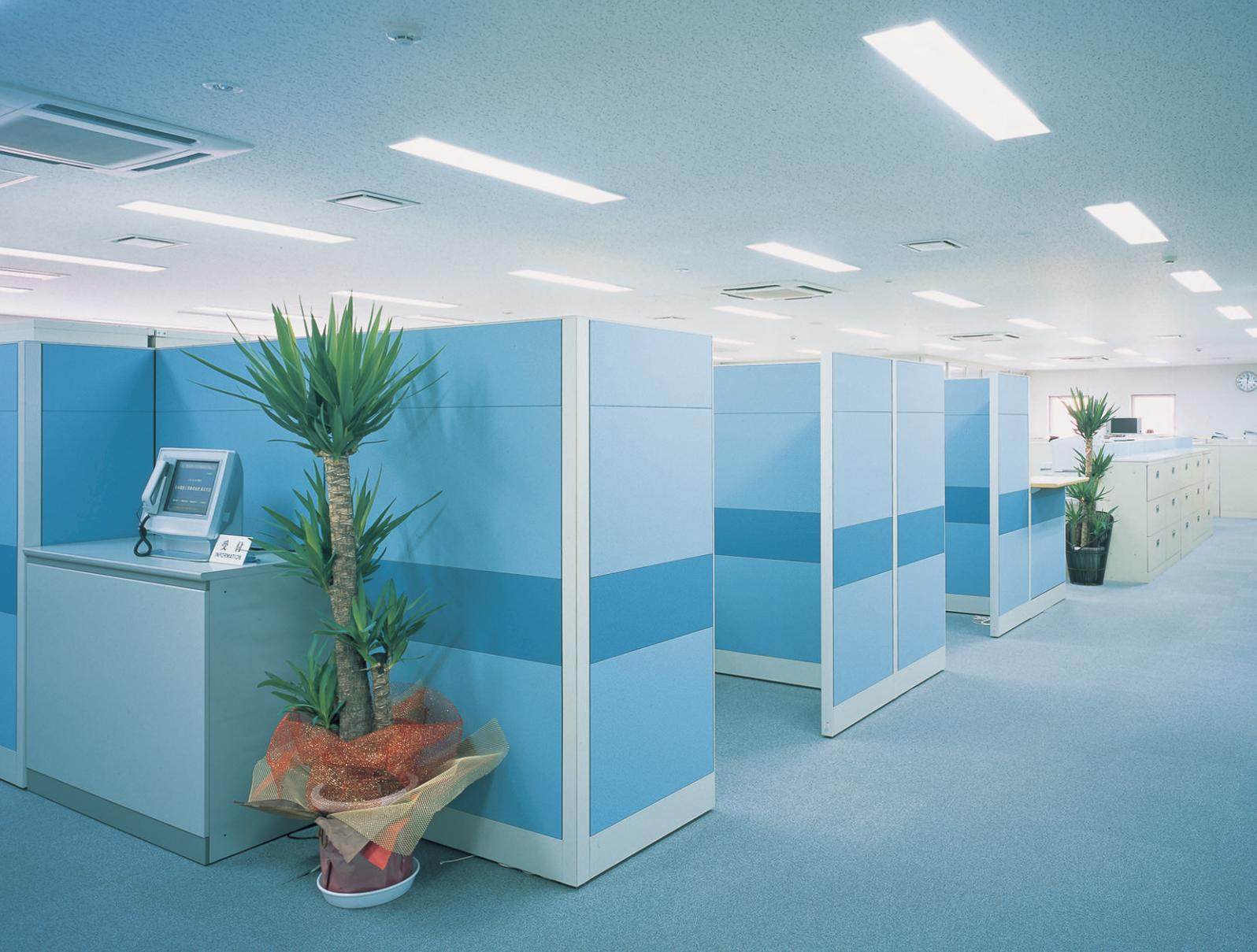
32WHf蛍光ランプ2灯用埋込器具(連続調光形)を採用しているオフィスフロア打合せコーナー周辺の照明
