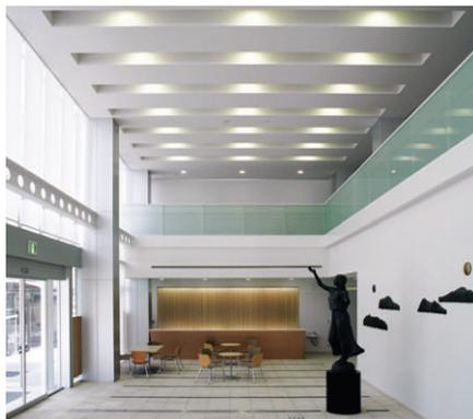
エントランスホール：スリット形の天井にダウンライト(FHT42W×2)を埋込み、天井にリズミカルな光パターンを形成
