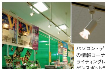
ドリンクコーナーから店内奥を望む：ベース照明に薄形直付4灯用スクエア器具を均等配置
