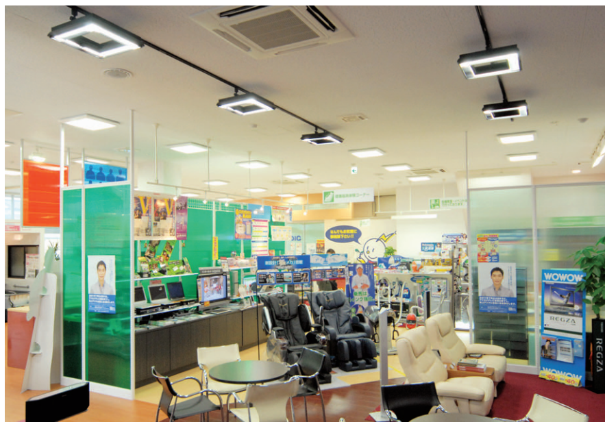
AVコーナー・健康コーナーの照明：ロフト天井向けスクエアベースライト(シェイプ)を採用。壁面周辺にはウォールウォッシャータイプ(シェイプ)を設置し、広がり感を創出
