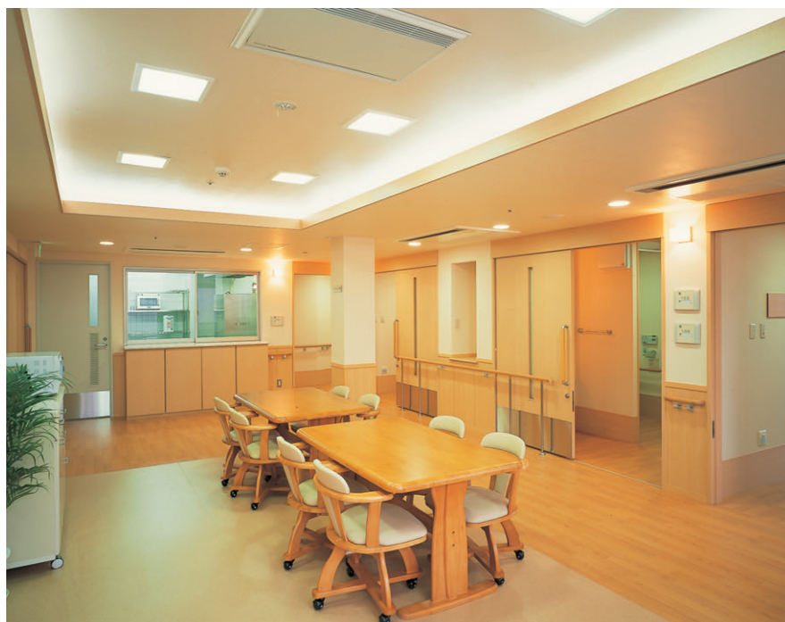
1階デイルームの照明：折り上げ天井の中央にスクエア器具を、側壁には間接照明を施し、テーブルを包み込む優しい明かりを形成
