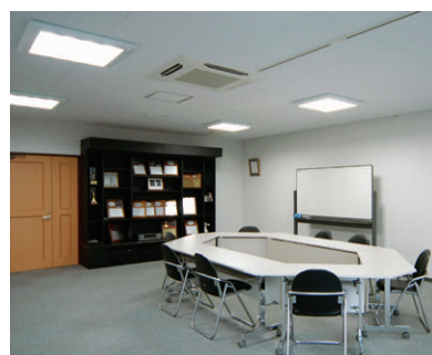
2階会議室の照明：薄形直付スクエア器具バッフル付を採用
