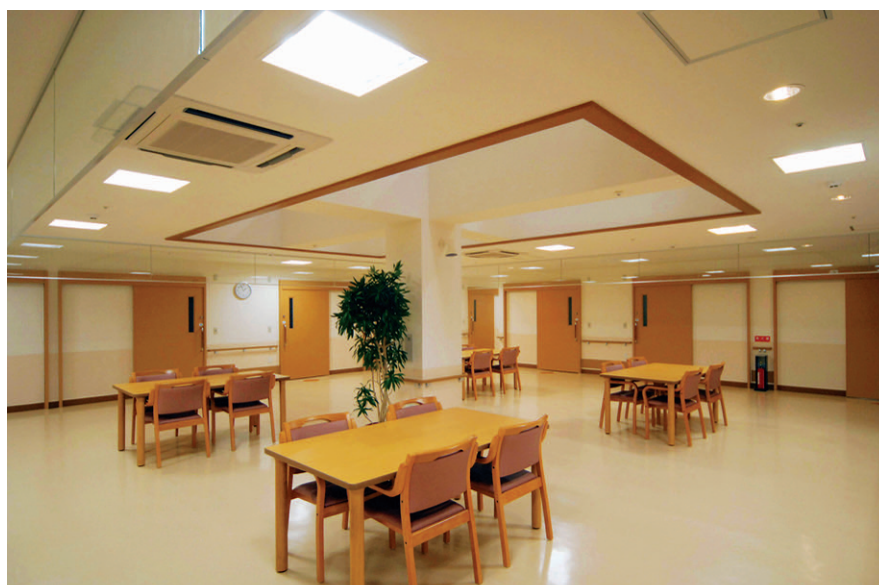
1階デイルーム兼食堂の照明：昼白色の4灯用スクエア器具を採用。高照度を確保しつつ、広がりのある落ち着いた照明環境を確保
