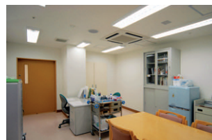
遮光角制御器具を採用した健康管理室の照明
