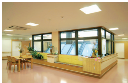
3階デイルーム兼食堂の照明：中央は吹抜けにより採光が得られている
