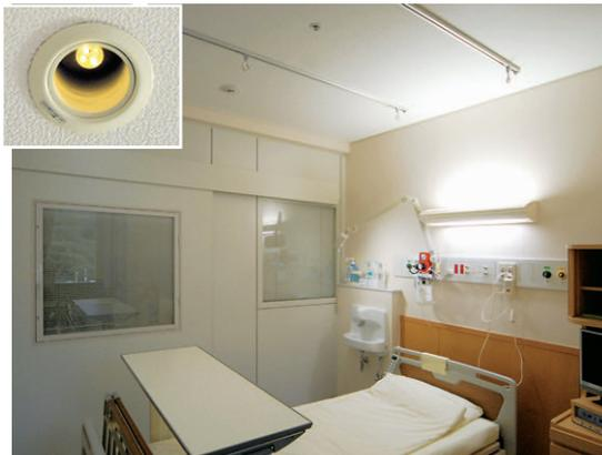
病室の照明：上下配光のベッド灯と可変タイプの処置灯使用。常夜灯にはLEDダウンライトを採用
