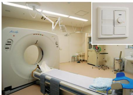
CT検査室の照明：埋込器具カバー付を使用し、操作室から5%~100%の調光が可能
