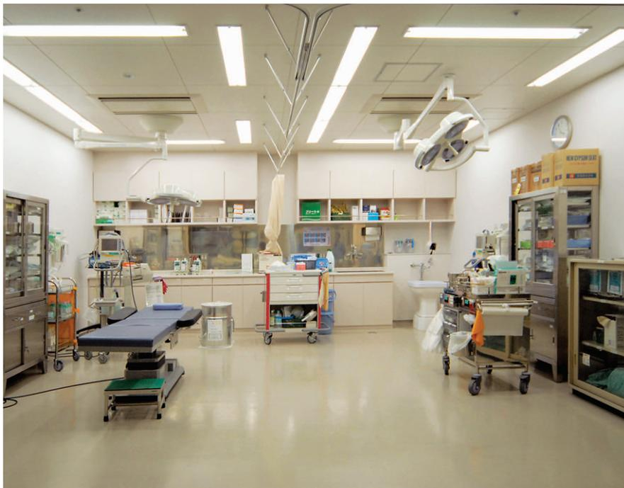
救急処置室の照明：埋込器具カバー付を口の字形に2パターン配置。調光可能として患者の容態に応じた的確な明るさを確保
