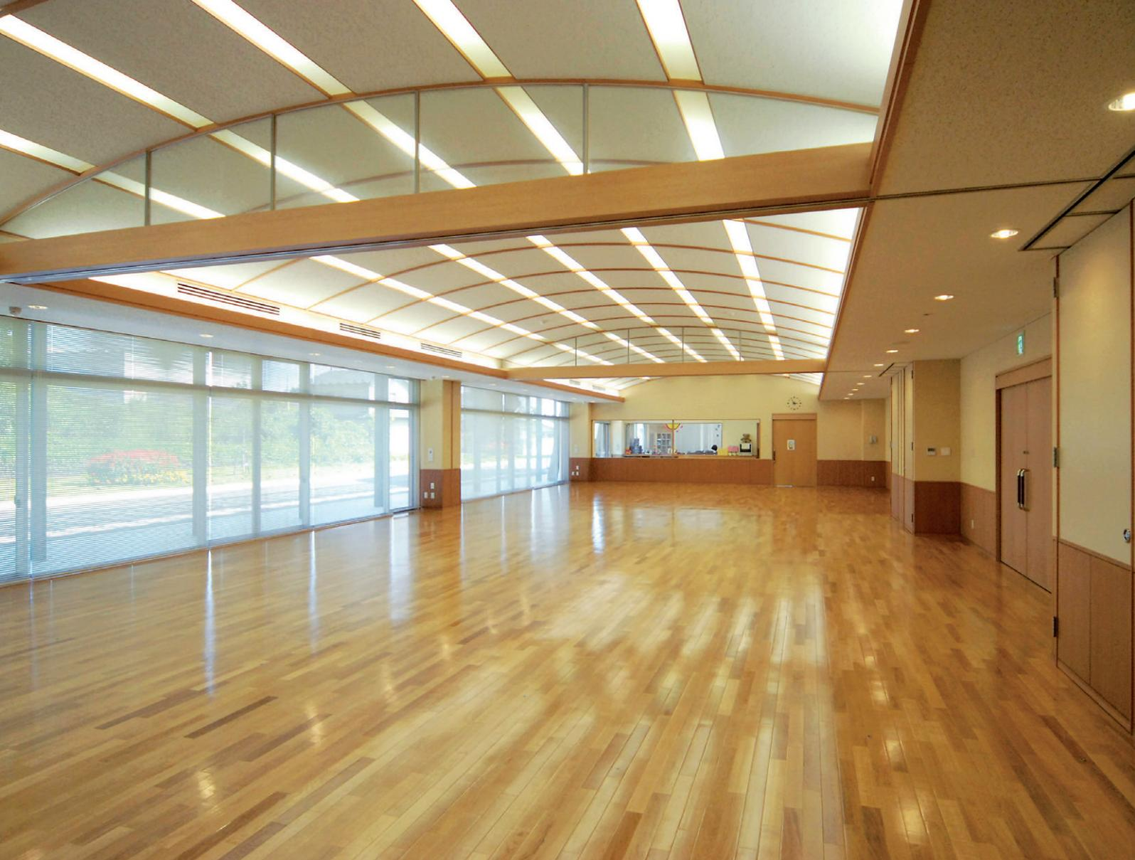
集団検診室の照明：建築化照明のスリット天井（下面乳白カバー付）内に笠なし器具（FHF32W）を連結設置し、天井周囲は間接照明。多目的に対応可能な明るさを確保しつつ、まぶしさを抑制
