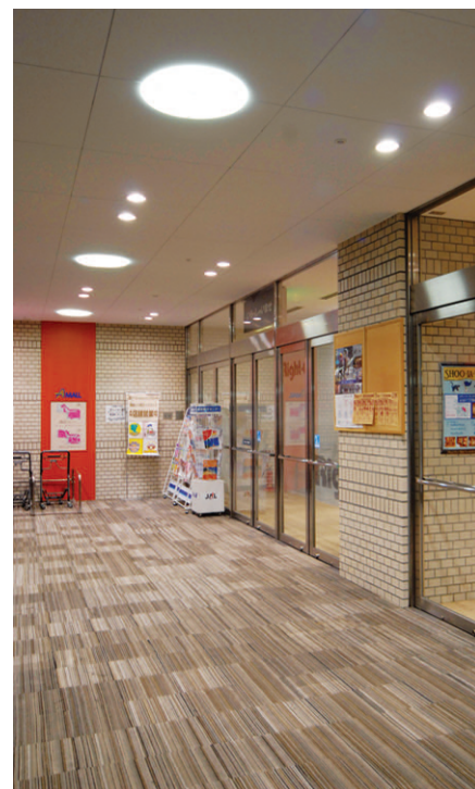
風除室：アクセントとして薄形で親しみやすい“セルーチェ”下面カバー付を設置。柔らかな光が入店者を出迎える
