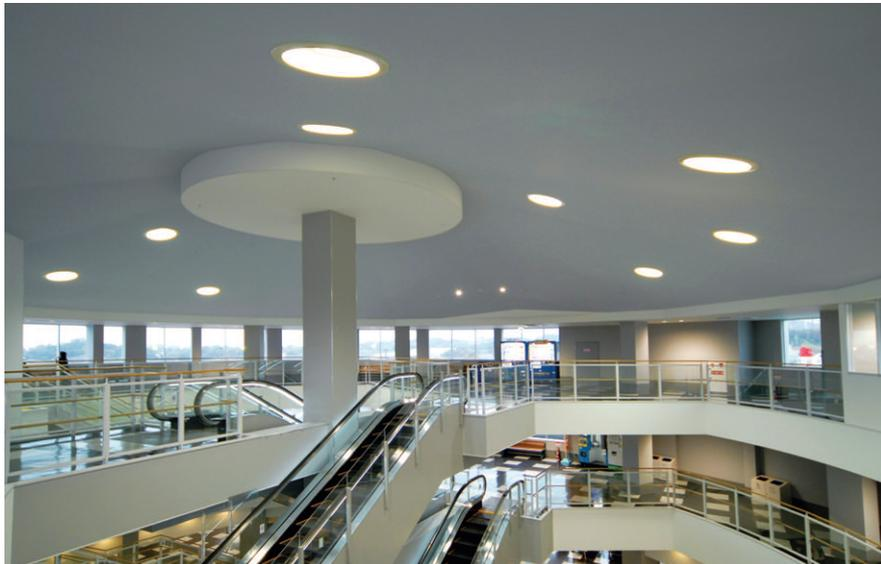
400Wメタルハライドランプダウンライトが配置されている中央エントランスホールの吹抜け天井部
