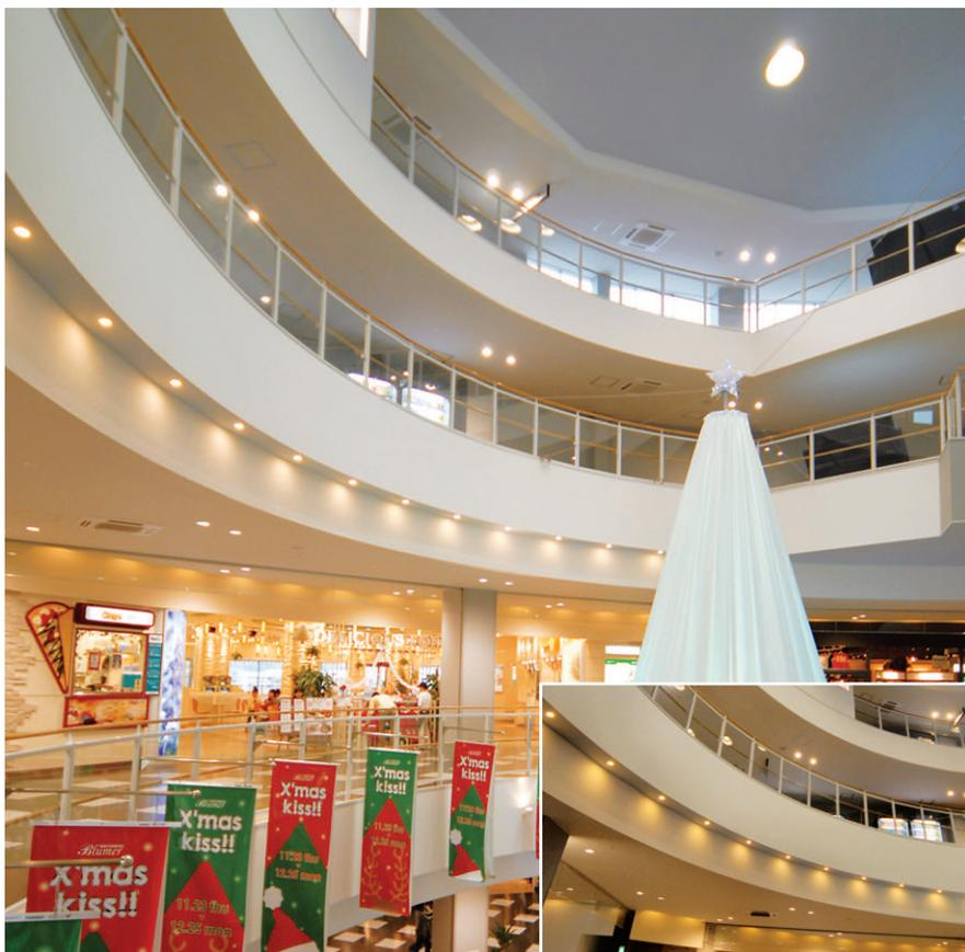
中央エントランスホールの照明：吹抜け天井部に設置したオートリラ付ダウンライト(MF400W)で照度を確保、エッジラインには光のアクセントを添える小形ダウンライト(EFD15W)を配置
