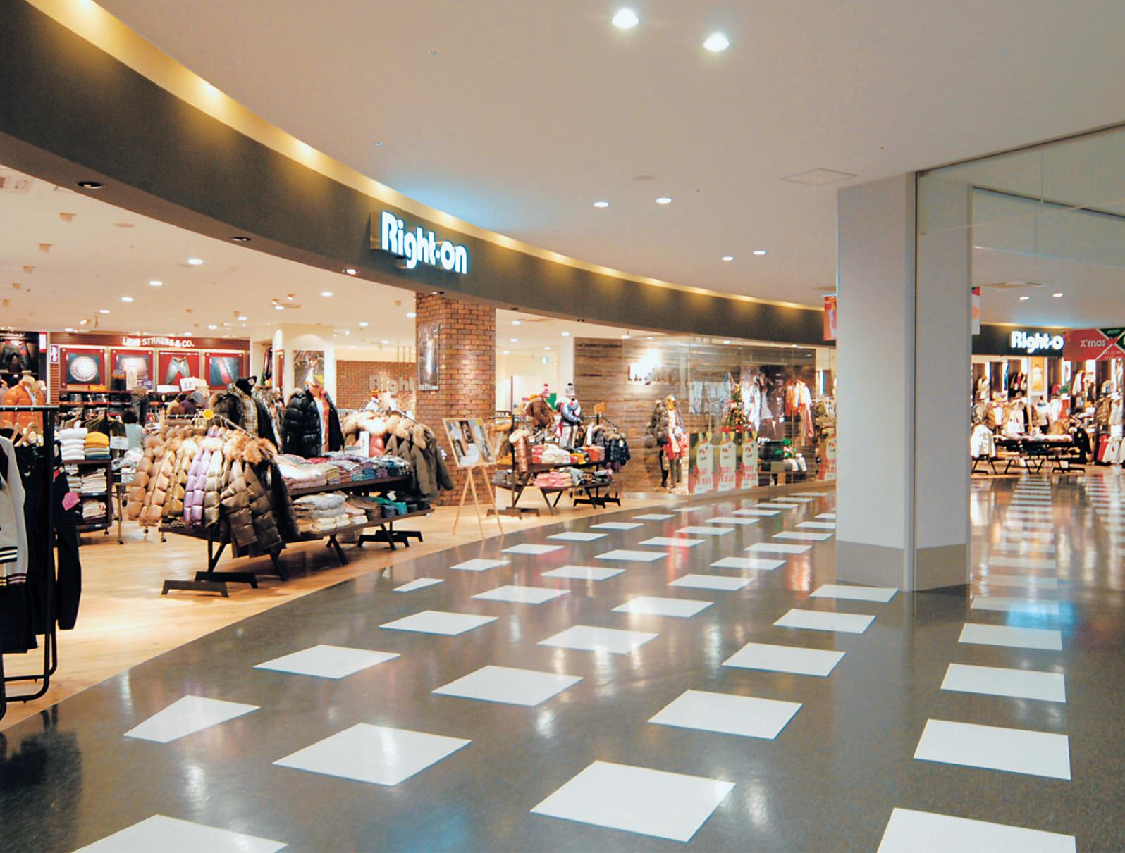
メイン通路曲線部の照明：ベース照明にHIDダウンライト（150Wネオセラ）2台を組にして配置。両サイド折り上げ部には小形ダウンライト（EFD15W）で明暗の光パターンを照射
