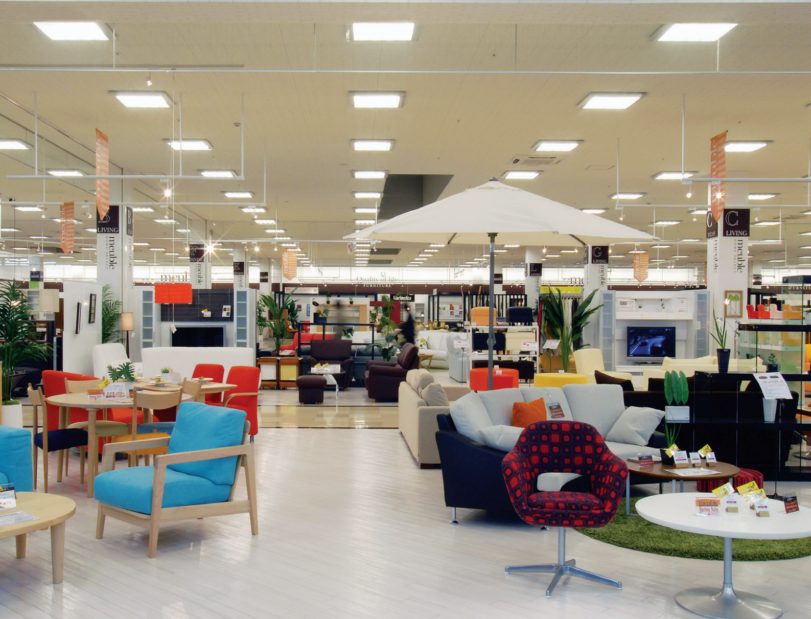
ホームセンター家具売場の照明：空間に方向性をつくらない正方形フォルムの薄形直付器具（FHP45W×4）を整列配置
