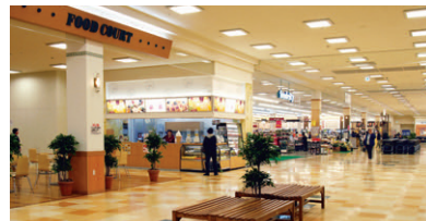
共用通路の照明：薄形直付スクエア器具（FHP45W×4）を採用
