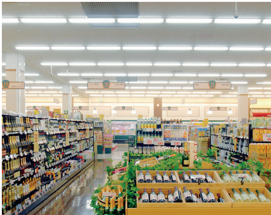
スーパーマーケットバローの内周ゾーン照明：32WHiP蛍光ランプ意匠重視形2灯用器具を採用
