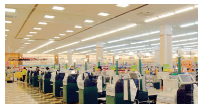
レジ周りの照明：薄形直付スクエア器具（FHT32W×4）を使用
