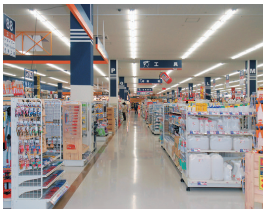
作業用品・工具売場周辺の照明：逆富士形器具（FHF32W×2）を連結配置
