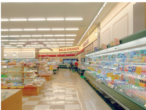
スーパーマーケットバロー外周ゾーンの照明：昼白色の内周ゾーンに対して外周ゾーンは電球色の光源を使用
