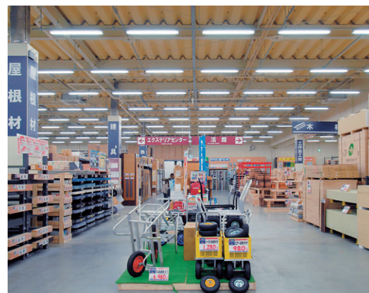
木材・建築資材売場の照明：レースウェイに反射笠器具（FHF32W×2）を床5mに設置
