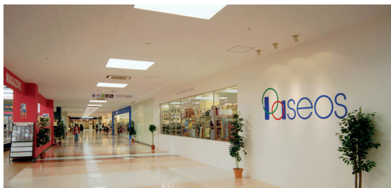
専門店街の通路照明：105WHfコンパクト形蛍光ランプ4灯用埋込器具バツフル付を設置
