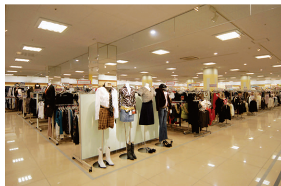
専門店街・洋品店の照明：ベースに4灯用薄形直付器具（FHP45W×4）とHIDダウンライト（100Wネオセラ）を混成して設置
