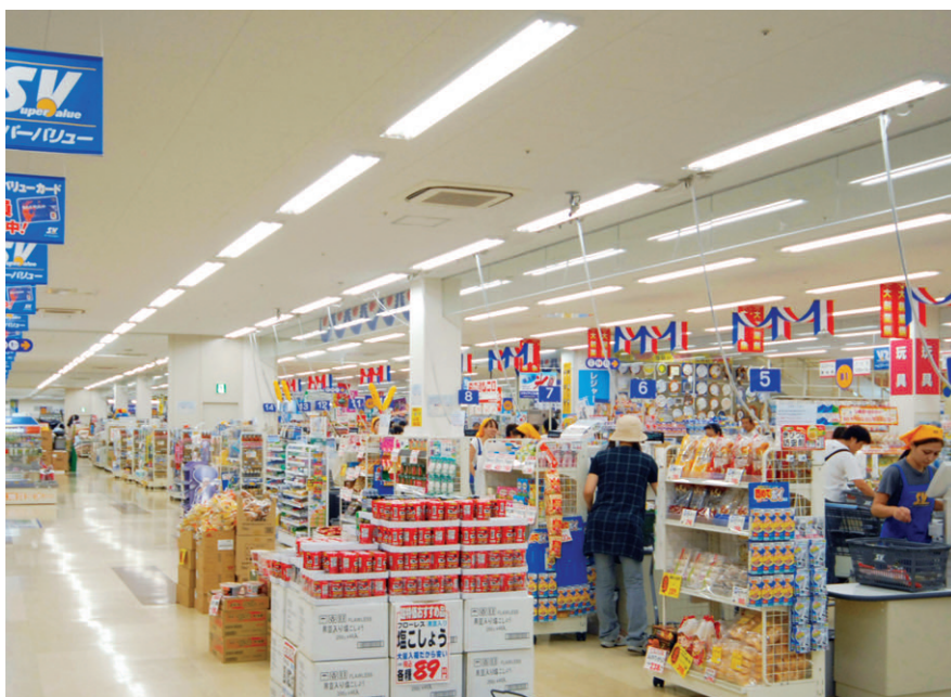
ベース照明に86WHf蛍光ランプ2灯用薄形直付器具を採用し圧迫感のないスッキリとした光のラインを確保
