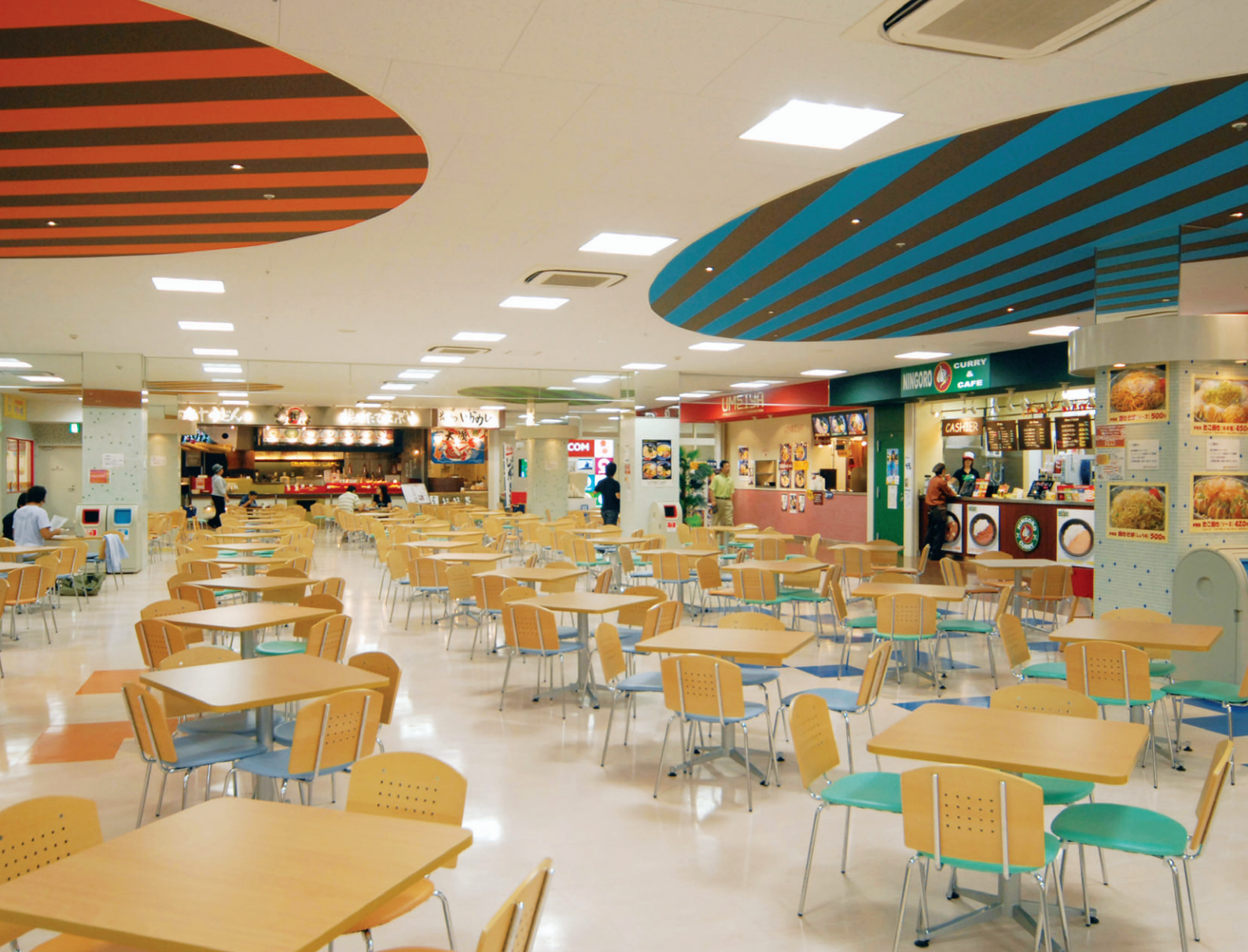
フードコートの照明：ベース照明に45Wコンパクト形蛍光ランプ3灯用薄形直付スクエア器具を採用。柱周りには50Wハロゲンランプダウンライトを配置
