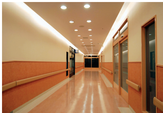
42Wコンパクト形蛍光ランプ3灯用ダウンライトを採用したクリニックモールの照明
