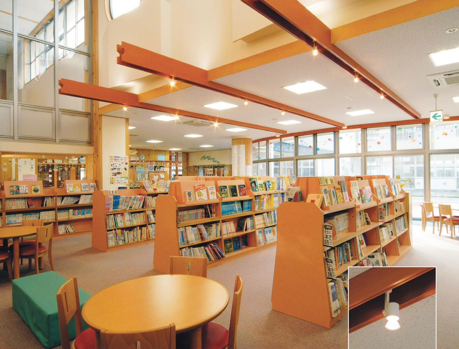
図書室の照明：ベース照明にスクエア器具 (FHP45W×3) を採用し、本棚の背文字を読みやすくするためのスポットライト (JDR60W) を使用
