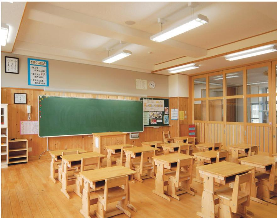
普通教室の照明:教室専用器具(スクールソフト)を採用し、教室中央にワイヤ吊下形を、その両側の下り天井には直付形を使用
