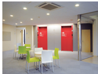
ダウンライトによるエレベータホールの照明
