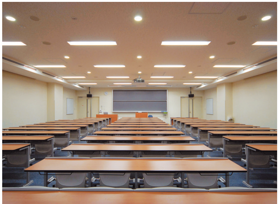
150人教室：埋込形調光器具＋照度センサで昼光利用制御。調光形ダウンライトでプロジェクタ使用時に対応
