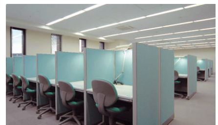
大学院研究室の照明：32WHf1灯用埋込器具＋照度センサを採用
