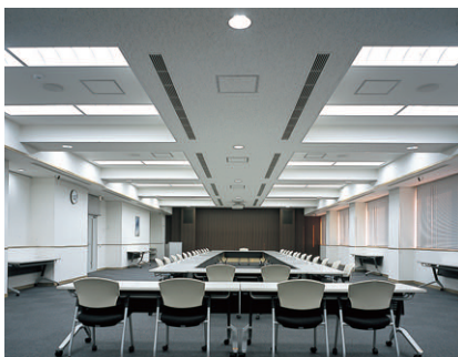
本館3階会議室の照明：乳白カバー付器具グレースベースライトを中央の下り天井の左右に2連結でライン配置。柔らかく、かつ明るい雰囲気を出し、会議内容の様々なシーンに対応可能な調光形ダウンライトも設置
