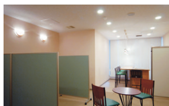
臨床心理センターリラクゼーションルームの照明：調光形のダウンライト、ブラケット、ペンダントを採用
