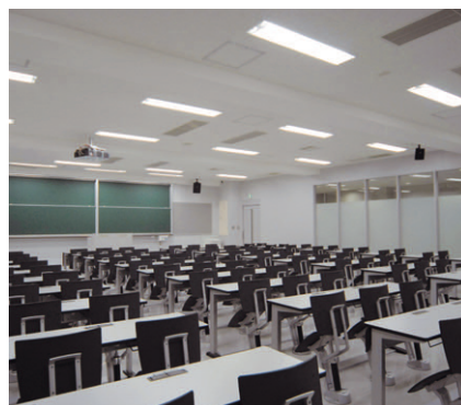
大教室の照明：スイッチパネルは、中・少人数にもムダなく対応できるよう、前・中・後の点滅回路としている
