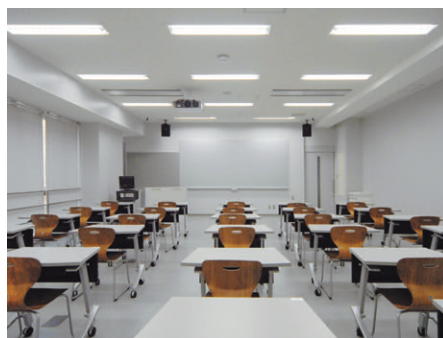
30人教室の照明：教室用に埋込遮光角制御形器具を、黒板灯には埋込ウォールウォッシャー器具を採用
