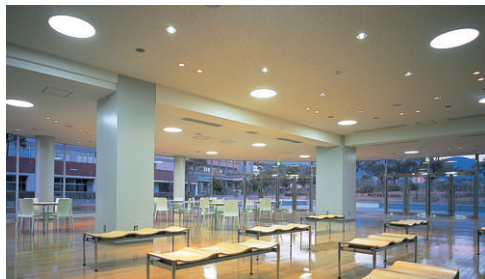
多目的ホールの照明：丸形の下面カバー付埋込器具とダウンライトの組合せて多彩なレイアウト
