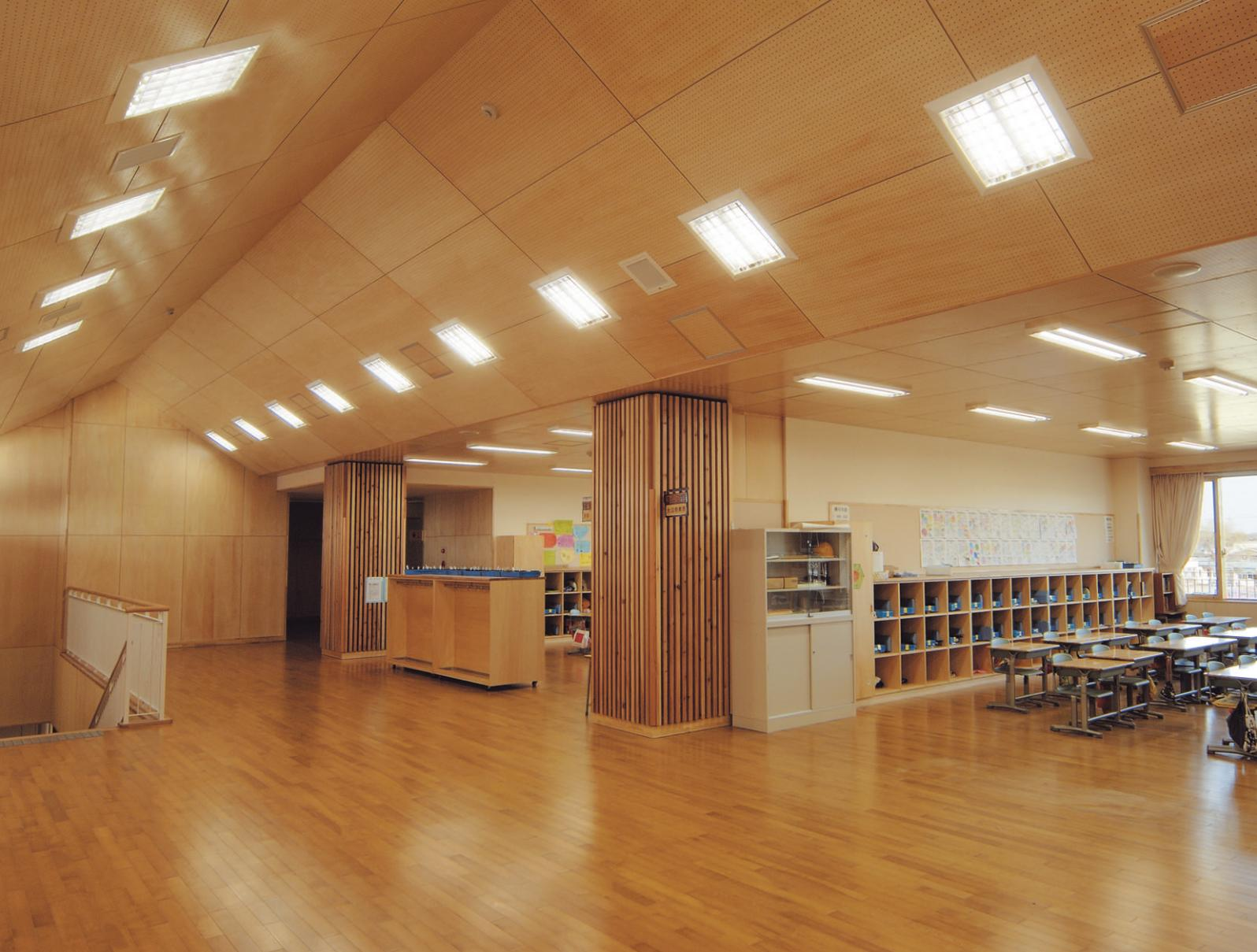
教室と連続的な空間となっている2階オープンスペースの照明：山形の斜め天井に薄形直付スクエア器具（FHP32W×3）を対向配置に設置
