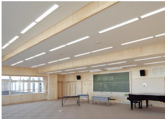
音楽室の照明：下面カバー付（プリズム）埋込器具2連結をライン配置
