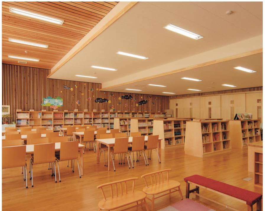
図書室の照明：32WHf蛍光灯2灯用埋込器具を中心に、中庭側のルーバ天井には薄形直付器具を設置
