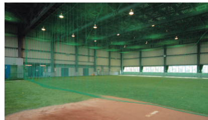
室内練習場の照明：400Wメタルハライドランプ高天井用反射笠器具（広照形）を防球ネット上部に均等配置
