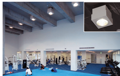
1灯用バンクライトを設置したトレーニングルームの照明
