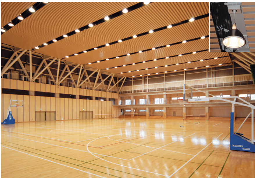
メインアリーナの照明：1kWメタルハライドランプ高天井用反射笠器具を建築化天井スリットのラインに沿って均等に分散設置
