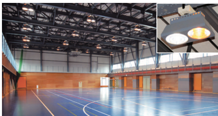
サブアリーナの照明：2灯用バンクライト（混光）を均等配置し、違和感のない光色で快適感を確保しつつ、省エネを実現
