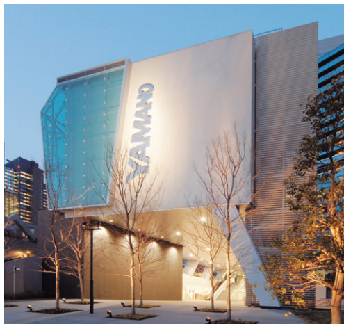
南西側外観の夜景：YAMANOの文字を明確に浮かせがらせるために、150WCMDM投光器で照射
