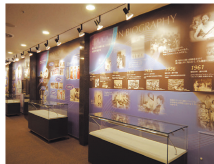
大講堂2階に設けられているギャラリーのスポット照明
