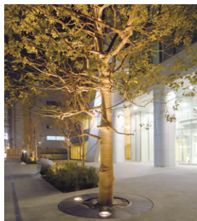
樹木は75W・150WCMDM地中埋込形器具でライトアップ
