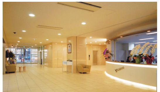
蛍光灯ダウンライトによるエントランスホールの照明
