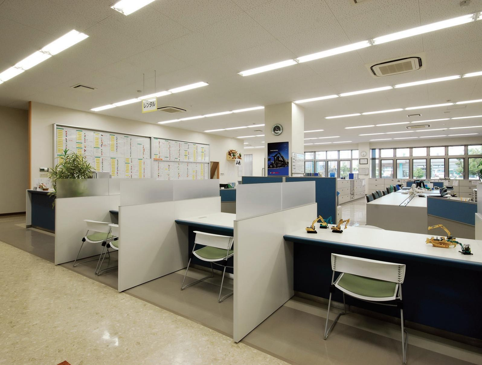
1階オフィスの照明：32WHf蛍光ランプ2灯用埋込開放Cチャン回避形器具を4連結にしてライン配置
