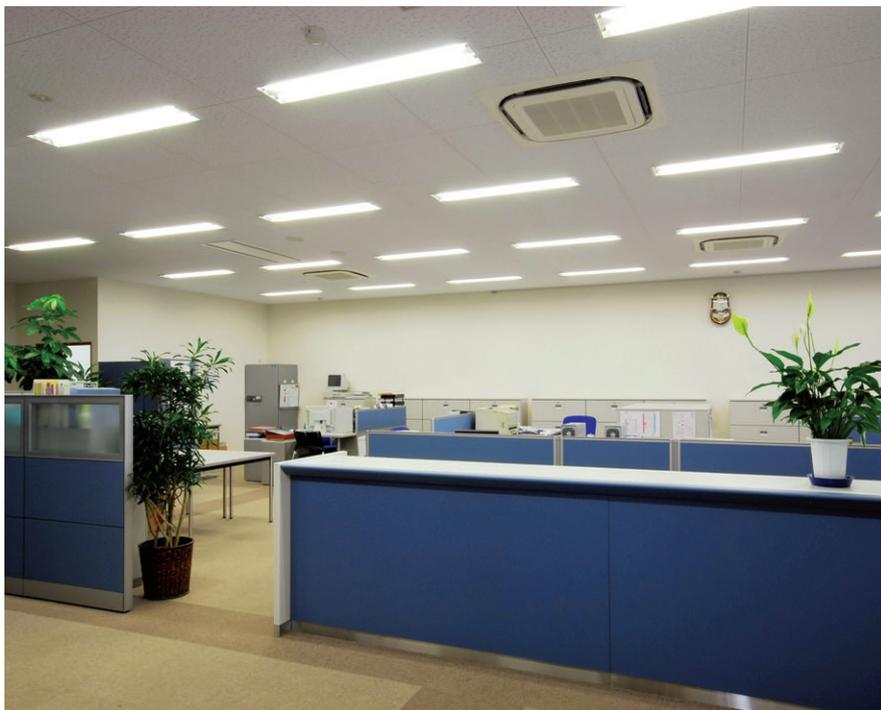
2階オフィスのカウンターから奥を望む：32WHf蛍光ランプ2灯用埋込開放Cチャン回避形器具をライン配置
