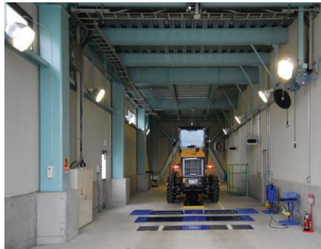
検査場の照明：両側面に投光器を、ピット内には2灯用反射笠器具ガード付き（FHF32W）を採用
