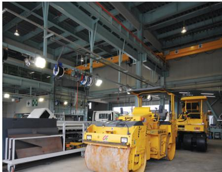
整備工場の照明：天井に高天井用反射笠器具（MT250W）を、両側面に投光器（MF400W）を設置
