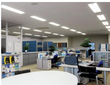
2階オフィスの窓側からカウンター方向を望む：1列ずつ間引き、一括の3回路点滅スイッチを設置
