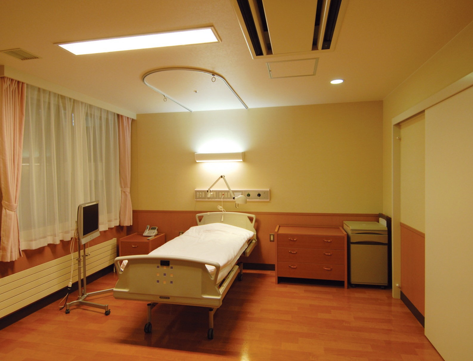
病室の照明 ベースに遮光角45°にグレアカット制御したバッフル付埋込器具ホスピタルソフトをベッド足元側通路に設置し、枕元上には間接照明・読書灯・常夜灯を一体化したホスピタルブラケットを採用
