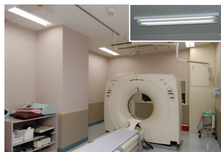
CT室の照明 薄形直付器具（FHF32W×2）を壁面近くに設置
