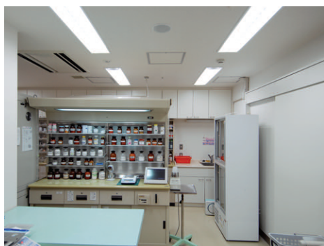
調剤室の照明 2灯用埋込器具バッフル付 (FHF32W)を使用し、隣接の無菌製剤室にはクリーンルーム用器具が採用されている
