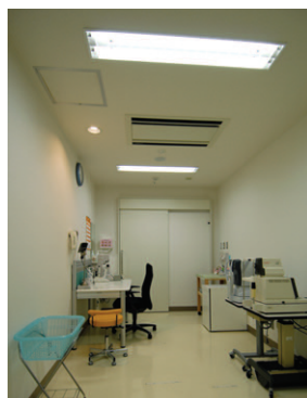
眼科診察室の照明 バツフル付Hf蛍光ランプ2灯用埋込器具調光形を採用
