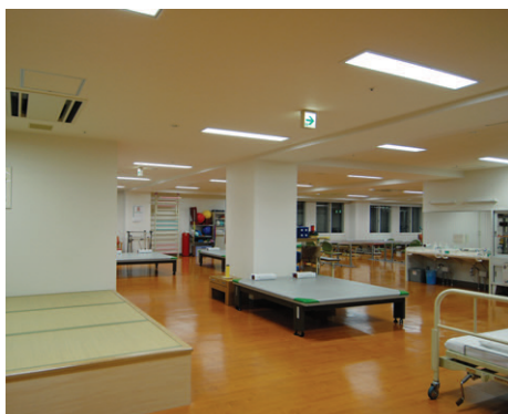
リハビリテーション室の照明 2灯用プリズムカバー付埋込器具 (FHF32W×2)による柔らかな光環境を創出
