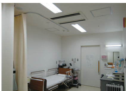
循環器科診察室の照明 バツフル付2灯用埋込器具（FHF32W×2）を使用
