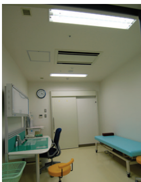
内科診察室の照明 32WHf蛍光ランプ2灯用埋込器具バツフル付を採用
