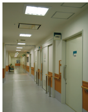
診察待合室・廊下の照明 4灯用埋込スクエア器具（FHP32W×4）を採用
