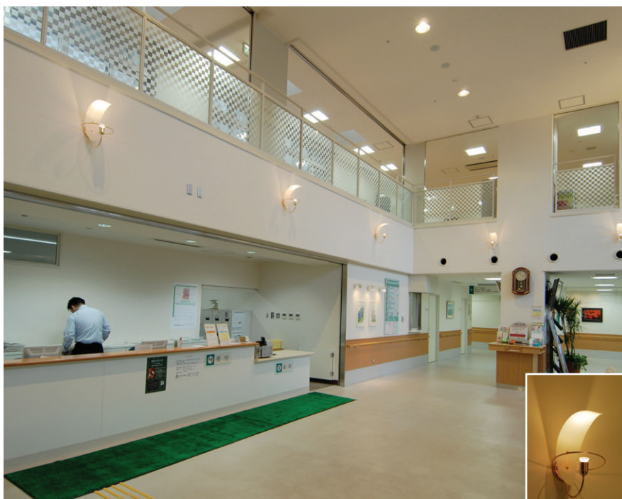
エントランスホールの照明 ベース照明にCDM150Wダウンライトを、壁面には45Wハロゲンランプブラケットを配置し、患者を迎え入れる和みの空間を演出
