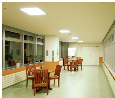
展望テラスの照明 4灯用埋込スクエア器具カバー付 (FHP32W×4)を採用
