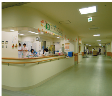
ナースステーションには2灯用埋込器具ルーバ付 (FHF32W×2)を使用、病棟廊下には4灯用埋込スクエア器具バッフル付 (FHP32W×4)を配置
