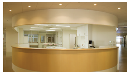
スタッフステーション ルーバ付埋込器具により、機器への映り込みを抑えている
