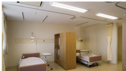
4床病室 主照明である32W Hf蛍光ランプ2灯用直付開放器具2台の他、アーム式ベッド灯により読書時に必要な手元の明るさを確保
