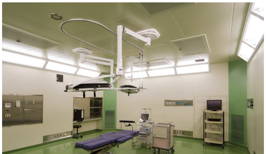
手術室 32W Hf蛍光ランプ2灯用クリーンルーム用直付器具を周囲に配置
