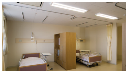
4床病室 主照明である32W Hf蛍光ランプ2灯用直付開放器具2台の他、アーム式ベッド灯により読書時に必要な手元の明るさを確保
