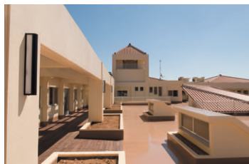
バルコニー 2Fバルコニーでは陽光を受けながら歩行練習が行えるスペースを確保。FL20W1灯用アウトアライトを壁側に据え付ける。沖縄伝統の赤瓦屋根が特徴的
