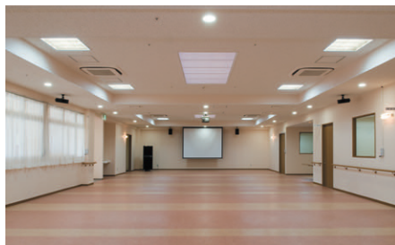
多目的ホール ホール中央に設けられたトップライトを中心にFHP45W4灯用埋込器具を等間隔に配し、その周囲を補助光として蛍光灯ダウンライトで囲む
