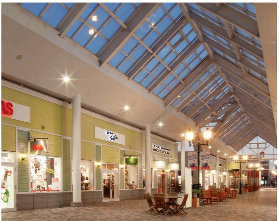
山形のガラス屋根のあるアーケードの照明 斜向壁のユニバーサルダウンライト(CDM-TP150W)で路面を照射。路面中央は街路灯(NH180W×2)を設けて雰囲気を高めている
