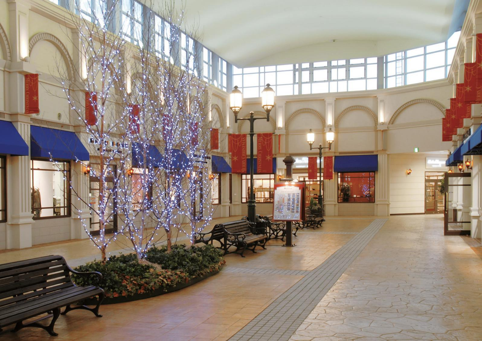
南欧風の「レラブロムナード」の照明 柱上部にスポットライト (JD130W) を設置し、建築意匠を際立たせている。全般の照明は壁面上部に設置した投光器 (MF250W) で天井に照射し、その柔らかな反射光で空間照度を確保
