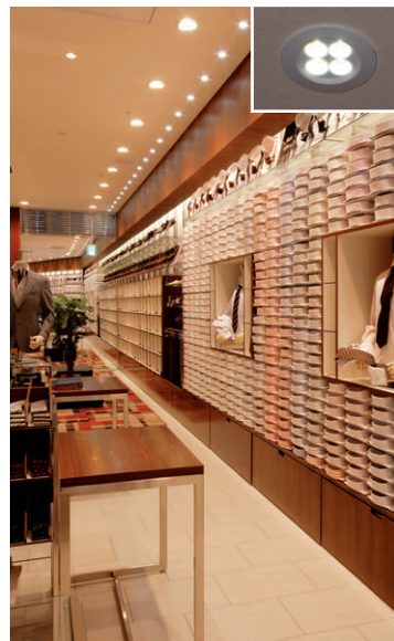
壁面展示ワイシャツ売場の照明 壁面のコーニス照明。上部壁へはLEDダウンライトで照射。壁面展示品へはCDMユニバーサルダウンライトで照明
