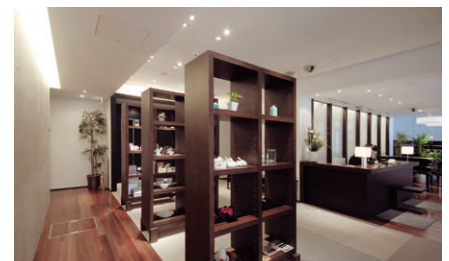
エントランスロビーの照明 空間に広がり感のある間接照明と、演色性のよいハロゲンランプユニバーサルダウンライトで展示品の色合い、形状を美しく表現
