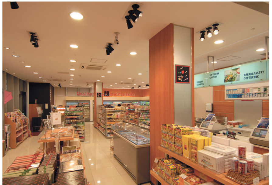
店内入口方向から店内奥を望む ベース照明に昼白色のコンパクト形蛍光灯ランプダウンライトを、重点照明にはハロゲンランプ3灯用チェイスウイングを配置
