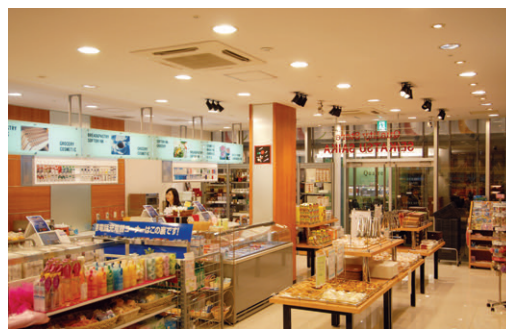
店内奥から入口方向を望む 指向性の光で商品に適切な鉛直面照度を確保し、商品を際立たせている
