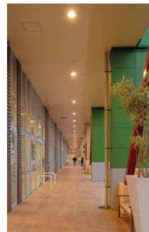
外通路 電球色のCDM軒下用ダウンライトを外通路に採用
