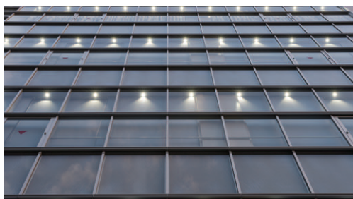
建物下から望む 1フロアあたり28台、2階から5階までの窓枠部分に計112台のE-CORE40ダウンライト中角タイプを設置
