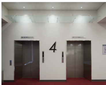
エレベータホール エレベータの乗降口の上部に設けられた乳白のガラス面に光を当てることによって、拡散した明るさ感を与える
