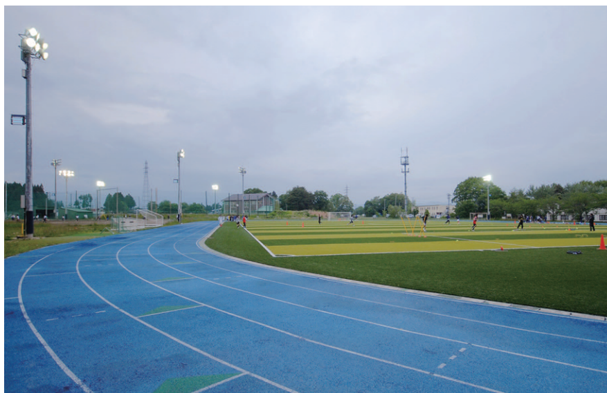
屋外グラウンド(陸上競技場・サッカー場)の照明 1.5kWメタルハライドランプ投光器搭載の照明ポール(高さ13.5m)によるナイター設備
