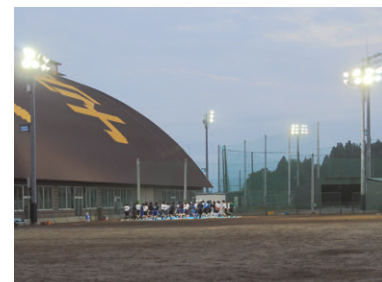
ソフトボール場の照明 投光器(M1.5kW)8台用架台の照明ポール2基を配置
