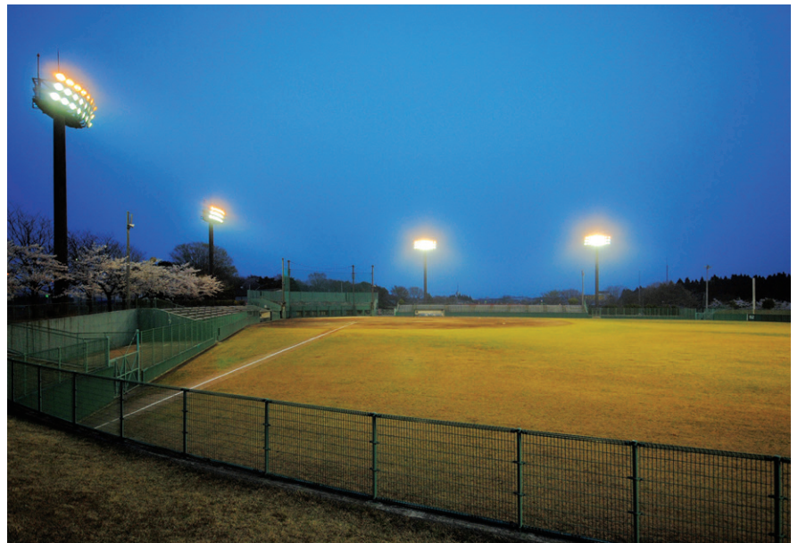
リニューアルされた軟式野球場のナイター設備 地上約20m高さの照明塔6基にM1.5kW投光器96台、NH940W投光器48台を配置
