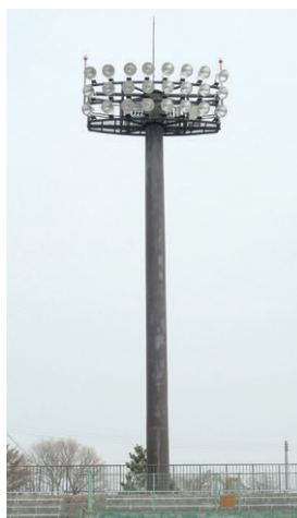
グラウンド周囲に6基設けられた照明塔
