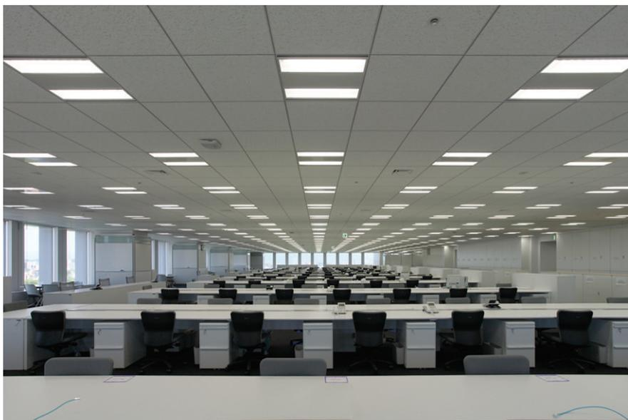
基準階 FHP45W2灯用白色バップル付600mm用ネオグリッドシステム天井用器具をベース照明として採用。あかりセンサとの連動で省エネ化を図る
