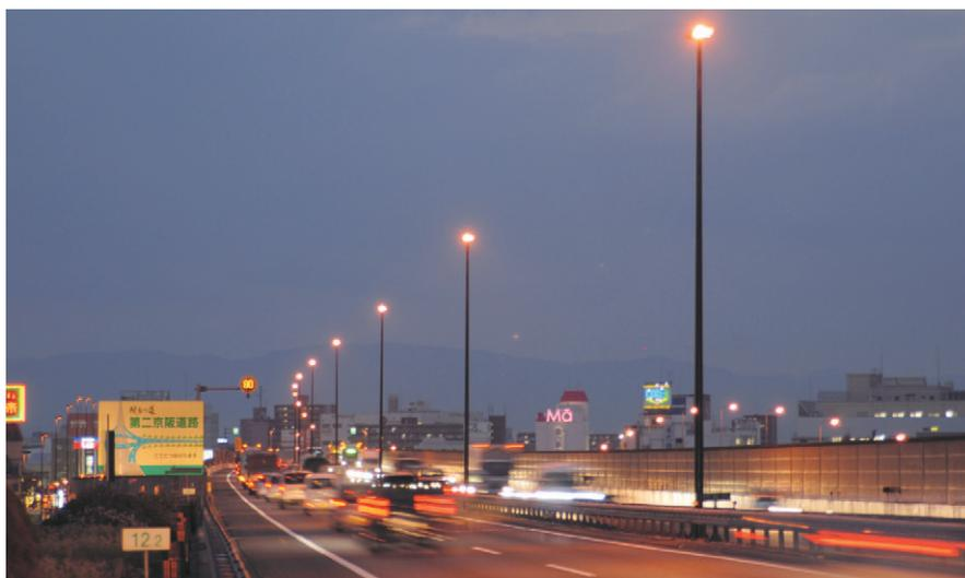
2車線区間全景 照明器具の設置間隔は既設基礎を使用した80mで、設置高さは12m。平均路面輝度は0.7cd/m<sup>2</sup>以上が確保されている
