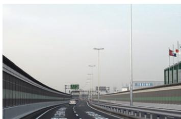
耐震性の優れたアルミダイキャスト製高圧ナトリウム灯器具を使用し、ランプは「ツインネオルックス-L」を採用
