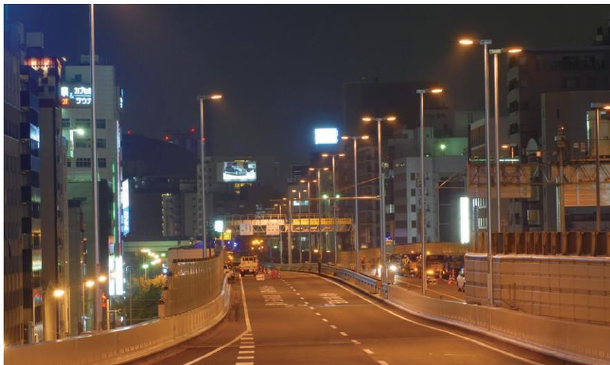
耐震性に優れたアルミダイキャスト製の高圧ナトリウム灯器具（プレアロード阪神高速仕様）+直線ポールを採用
