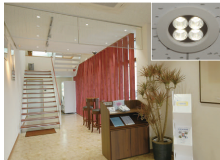
1階エントランスホールの照明 高効率LEDダウンライト(E-CORE40)を均等配置
