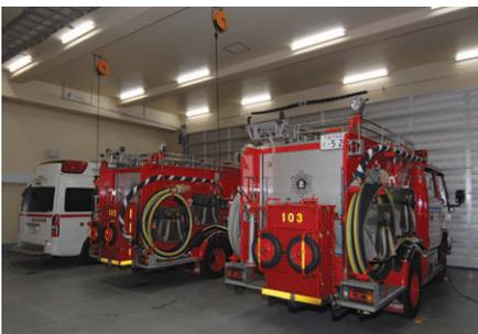
車庫の照明(Hf逆富士形器具を横付けで設置)
