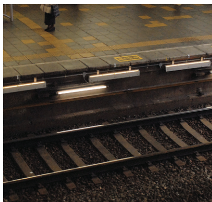
プラットフォーム下部の作業足場にLED足下灯を設置
