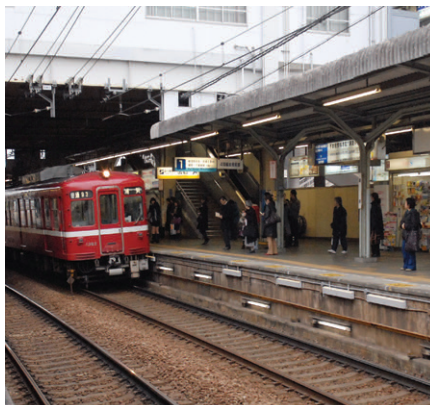
電車が停止してドアが開いた際、ドアとホームの隙間の注意を促すため、LED屋外用ラインモジュールをホーム下部に配置
