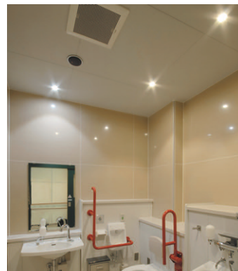
多機能トイレ 間口を広めにとり、車いすに対応した多機能トイレ内部。E-CORE40の光感が隅々までいきわたる
