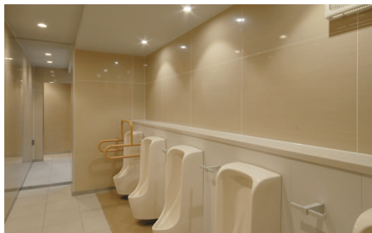
男子トイレ内 E-CORE40広角タイプを使用しているため、明るさが小便器周辺にまで十分に拡散される
