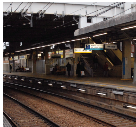
電車が停止してドアが開いた際、ドアとホームの隙間の注意を促すため、LED屋外用ラインモジュールをホーム下部に配置
