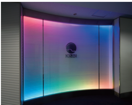
カラーLEDシステム 沖縄の「太陽」「空」「海」を表すVIカラーをモチーフに、光のパターンのプログラムが組込まれた
