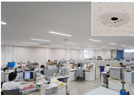
事務フロア パソコン画面への映り込みを軽減するためHf32W2灯用バッフル付蛍光灯器具を採用。快適なオフィス空間を創り出す
