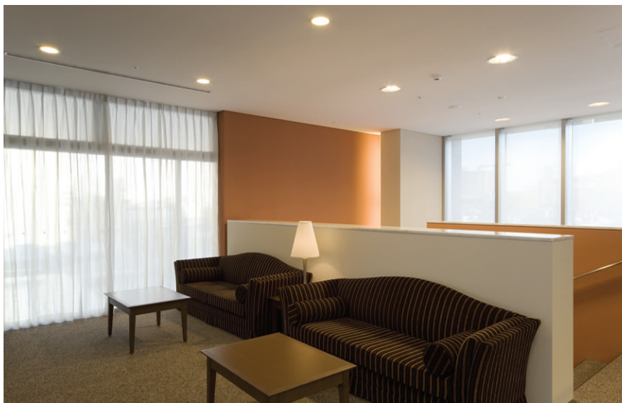
ロビー FHT32W1灯蛍光灯ダウンライト白バツフルを等間隔で配置して上質な雰囲気を創り出す
