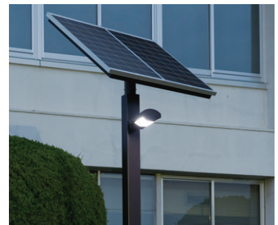
ソーラーパネル式外灯 夜間は昼間充電したバッテリーの電力を利用してLED照明を点灯
