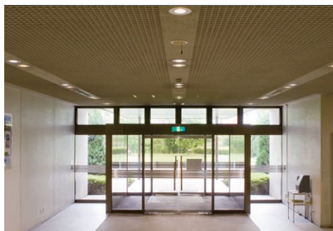
リニューアル後のエントランス E-CORE60リニューアルプレートΦ150用を2台1組で配置。
