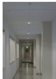
1階見学通路の照明 常夜灯にE-CORE60を使用し、見学の場のみ、人感センサ連動のHf埋込器具(2灯用)をON-OFF制御
