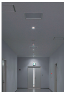
1階廊下の照明 E-CORE60を常夜灯として使用し、来客時の場合のみHf埋込器具を点灯し、省エネが図られている
