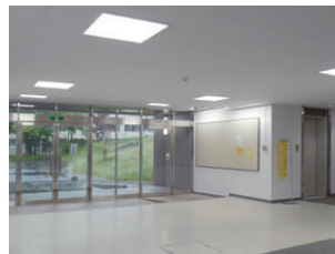
廊下の照明 32WHf蛍光灯1灯用埋込器具と人感センサとの連動で、人が居ない時は25%に減光
