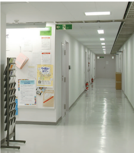
廊下の照明 32WHf蛍光灯1灯用埋込器具と人感センサとの連動で、人が居ない時は25%に減光
