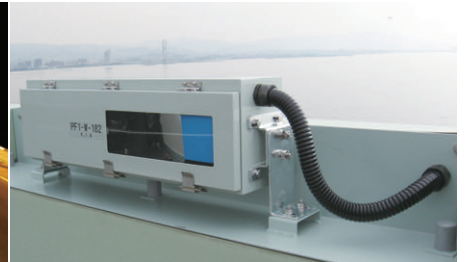
全点灯 降雨時や濃霧時には全点灯にして安全を確保する 器具アップ 12.5m間隔で片側145台計290台を設置している
