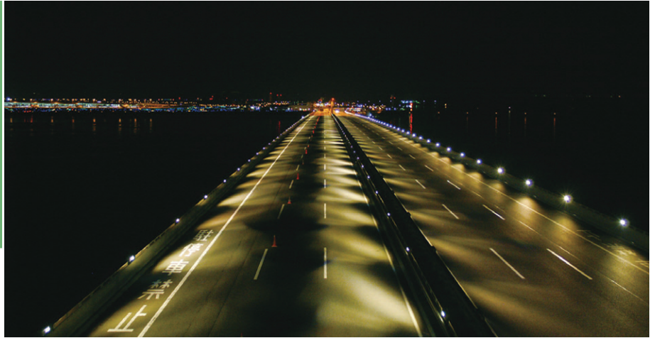
低位置プロビーム方式 進行方向へ向けて照射させることにより運転者に眩しさを与えないだけでなく、逆シルエット効果により障害物の発見がしやすくなる
