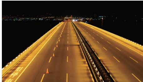
全点灯 降雨時や濃霧時には全点灯にして安全を確保する 器具アップ 12.5m間隔で片側145台計290台を設置している
