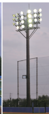
19m高さの照明柱
