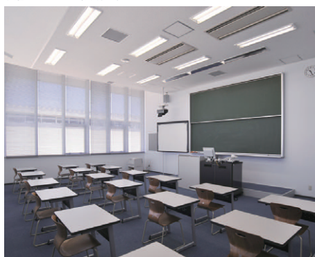
システム科講義室の照明 Hf32W2灯用埋込器具を採用。前1列は調光形。黒板の反射によるグレアを軽減
