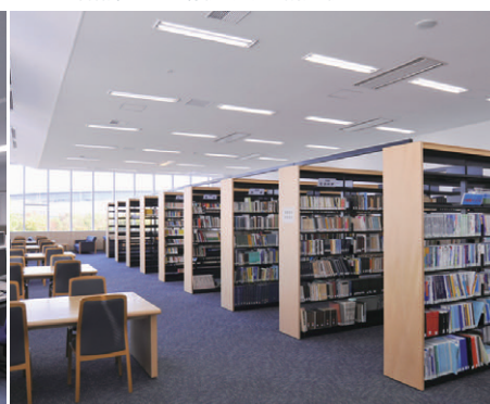
図書室の照明 Hf32W2灯用埋込器具の初期照度補正制御と窓側は昼光利用制御を採用
