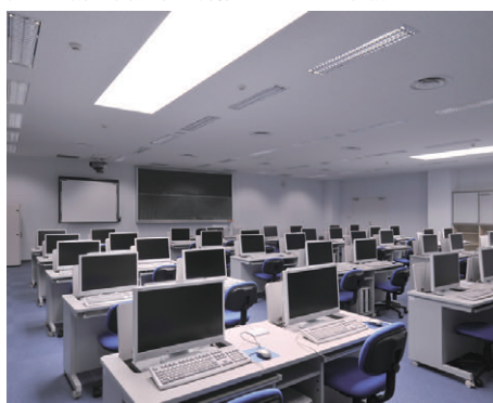
第1総合システム実習室 Hf32W2灯用OAルーバ付埋込器具を採用
