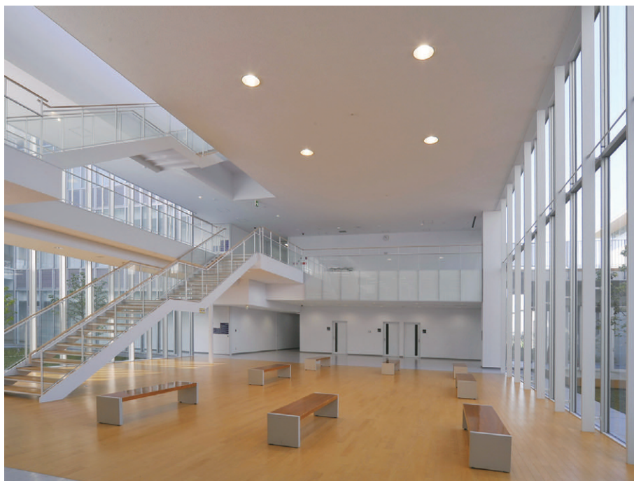
吹き抜けロビーの照明 両サイドのガラス張りカーテンウォールからの昼光とのバランスを配慮し、MF400Wダウンライトを採用
