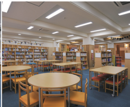
メディア教室・図書室の照明 コンピュータ室と同様器具で目の負担を軽減しつつ省エネ
