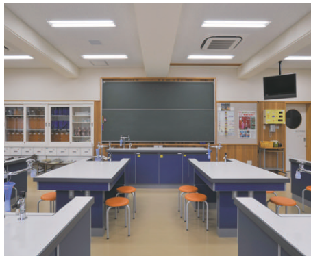
アトリエの照明 32WHf2灯用薄形直付器具を採用
