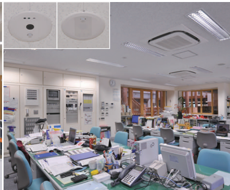
32WHf2灯用埋込器具OAルーバ付を採用し、照度センサ＋人感センサとの連動で減光制御し、省エネを図っている職員室
