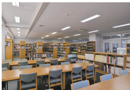
図書室の照明 埋込器具開放形により明るく、本棚の背文字も読みやすく配慮
