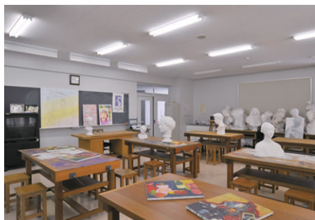
美術教室の照明 逆富士器具を採用し、天井面、壁面も明るくして輝度差を軽減
