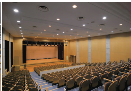
ダウンライトをベース照明とした視聴覚教室の照明
