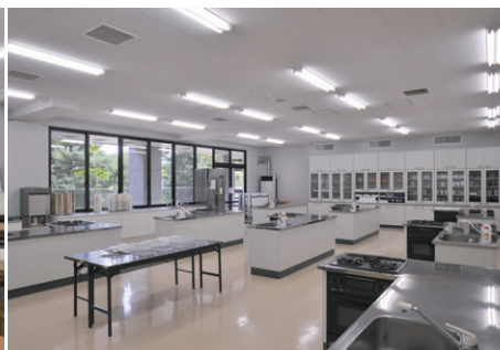
調理教室の照明 耐食性に優れたステンレス防水形逆富士器具を採用
